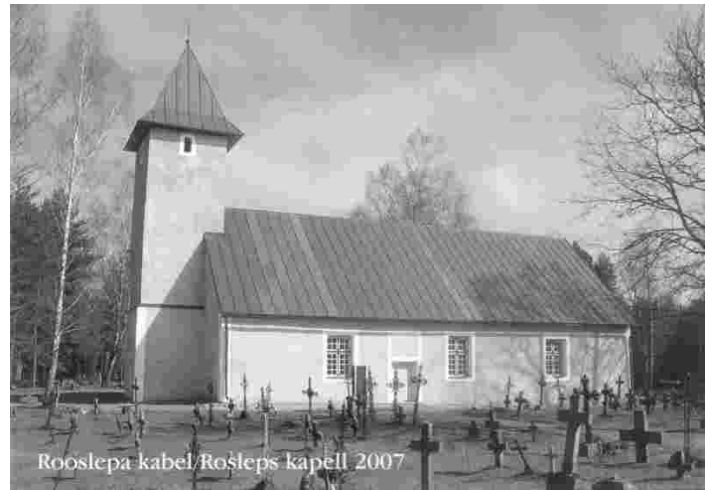
Peatselt taaspühitsetav Rooslepa kabel Läänemaal
